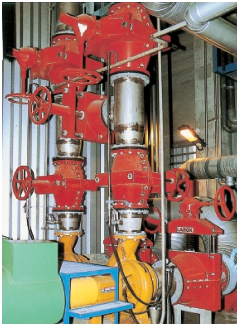
Вентили с ручным приводом используются обычно в процессе рекаустификации.
